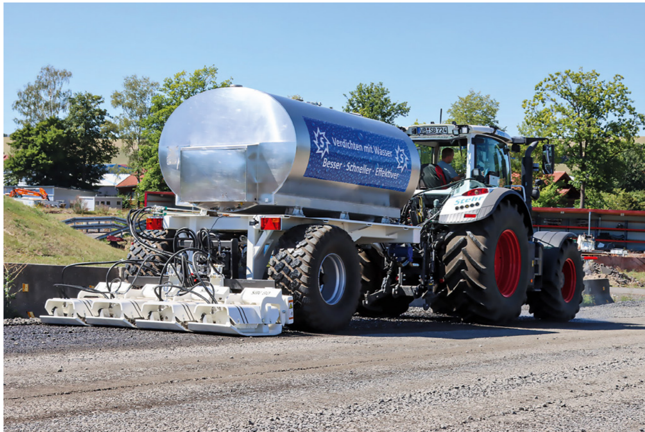
Der Wasserwagen mit angehängten Plattenverdichtern verspricht laut Stehr optimale Verdichtungsergebnisse mit weniger Energie, weniger Kraftstoff und weniger CO 2 -Erzeugung. (Bilder: Stehr Baumaschinen)
