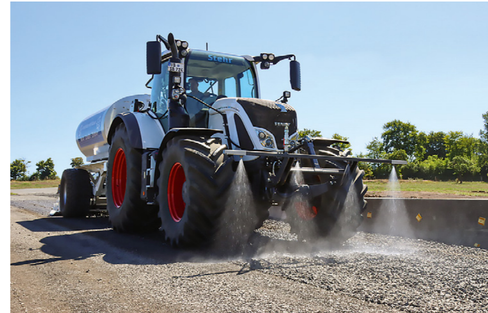
Über eine stufenlos dosierbare Hochdruckpumpe wird das Wasser mit hohem Druck etwa 10 m vor die Plattenverdichter aufgebracht.
